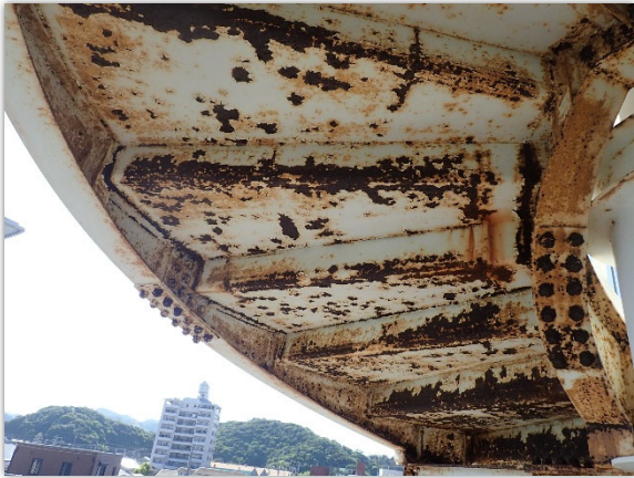
写真1. 鋼桁の腐食
