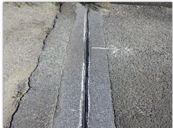
写真6. 路面の段差
