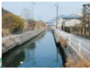
立岩水尻川(大桑島) 石積み護岸にニオ川の券面気が残る
