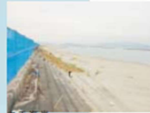
大手海岸 砂浜沿いには高い堤防が整備されている
