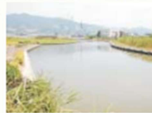
大谷川下流 農地の間を大きく蛇行しながら流れている
