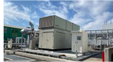
コージェネレーションシステム（鳴門工場） （出典：大塚製薬工場 HP）
