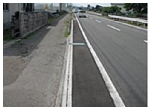
路側の改善（側溝の改修）
