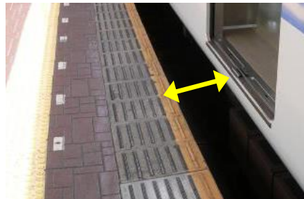
ホームと車両の間が大きく開いた事例
