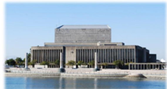
撫養川東岸から文化会館を望む
