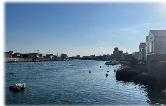
開放感のある撫養川沿いの景色（現況）
