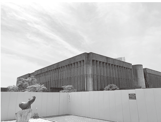
令和9年6月のグランドオープンを目指し耐震改修工事中の文化会館
