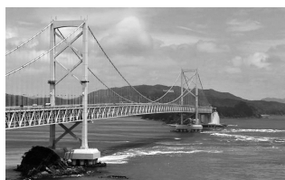
令和9年度の自転車道開通を目指し整備中の大鳴門橋
