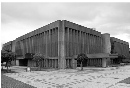
耐震改修工事前の鳴門市文化会館
