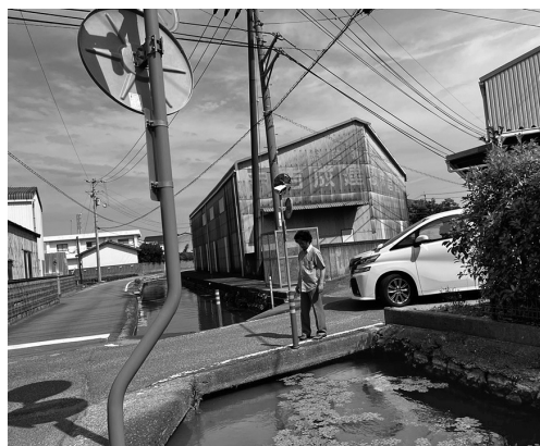
土砂の堆積により水位が上昇している水路
